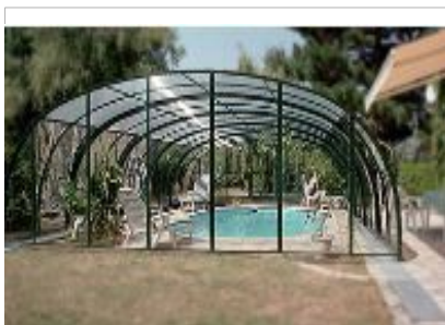
Figure 12: piscines couvertes et enterrées
