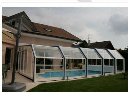
Figure 11: piscines couvertes et enterrées
