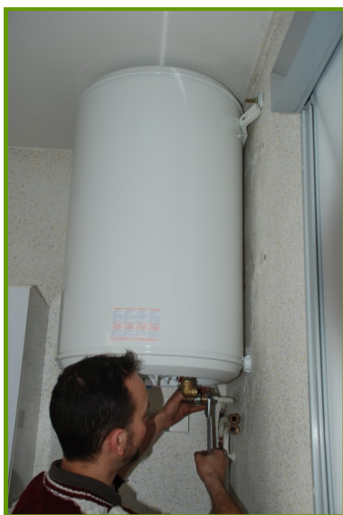
Remplacement du chauffe-eau
